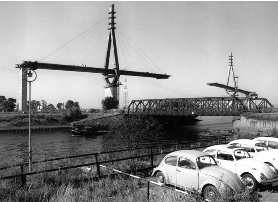
Die Brücke im Bau
