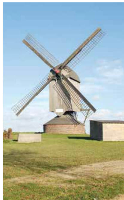
Die Düppelsmühle ist eine Bockwindmühle. Bei diesem Typ wird der Mühlenkasten mit den Flügeln in den Wind gedreht. Foto: Achim-Raschka / Wikimedia Commons, 2009
