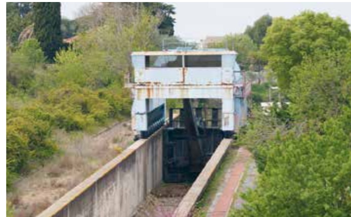
Wie ein Riesen-Insekt fuhr der Wagen des Wasserkeil-Schiffshebewerkes Fonseranes über der Kanalrinne. Foto: Werner Schleser 2019
