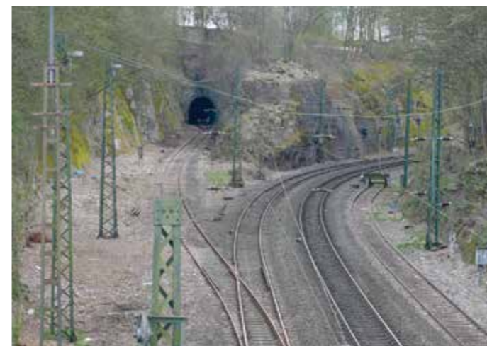
Die Strecke zwischen dem Güterbahnhof Wuppertal-Langerfeld und Oberbarmen führt direkt am Nordportal des Langerfelder Tunnels (links) vorbei. Foto: Andreas Fahrrad / Wikimedia Commons, 2013
