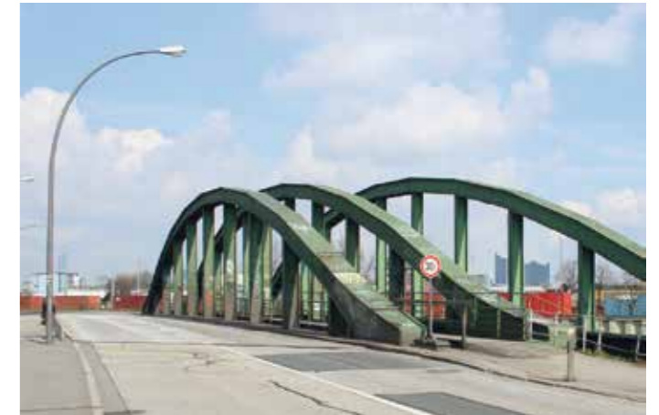
Die für Straße und Bahn parallel verlaufenden Veddelkanalbrücken sind 1933/34 errichtete Stabbogenbrücken. Foto: Sven Bardua, 2016
