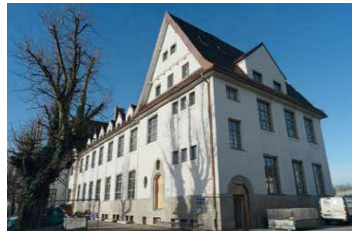
Das Gebäude der Papierwarenfabrik Niedermayr in Rosenheim ist ein mit Ziegeln ausgefachter und verputzter Eisenbetonskelettbau von 1911/12. Foto: Hasit Trockenmörtel GmbH, 2018
