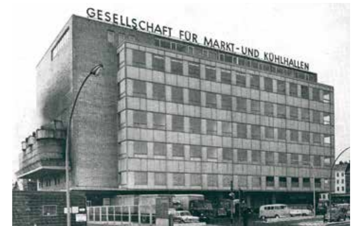
Das MUK-Kühlhaus in Hamburg verfügte zur Lagerstraße hin über Büroräume. Foto aus: Beton- und Monierbau AG 1889-1964, Düsseldorf 1964
