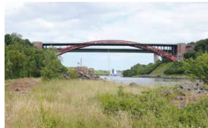
Die 1893/94 errichtete Levensauer Hochbrücke ist die letzte aus der Bauzeit des Nord-Ostsee-Kanals. Foto: Sven Bardua, 2018
