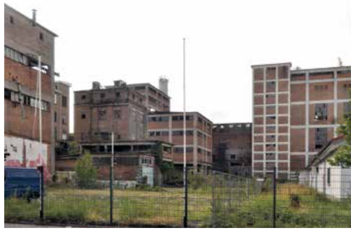
Die Stahlbetonskelettbauten der 1950er Jahre prägen die Zellulose- und Papierfabrik in Hattersheim-Okriftel. Foto: Norbert Gilson, 2017
