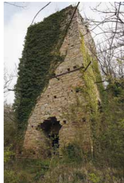
Zahlreiche Risse beeinträchtigen die Stabilität des Kalkofens von Soultz-les-Bains im Elsass. Foto: Werner Schleser, 2019
