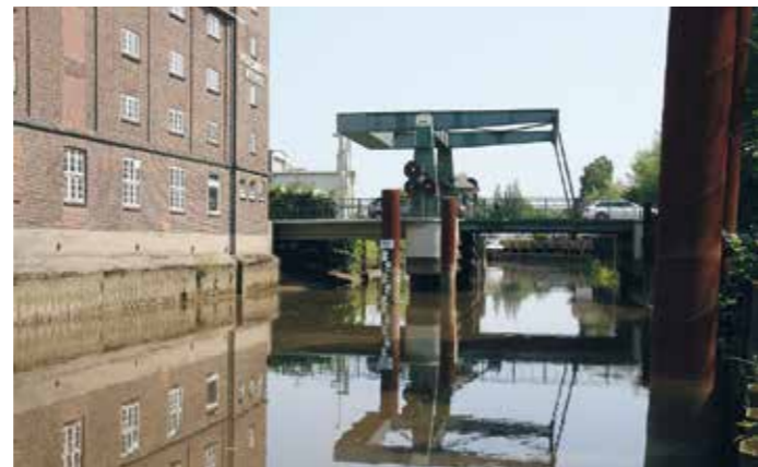
Die in Uetersen über die Pinnau führende Klappbrücke ist etwa zwölf Meter tief gegründet und hat eine Stützweite von 40,40 Meter. Foto: Sven Bardua, 2013
