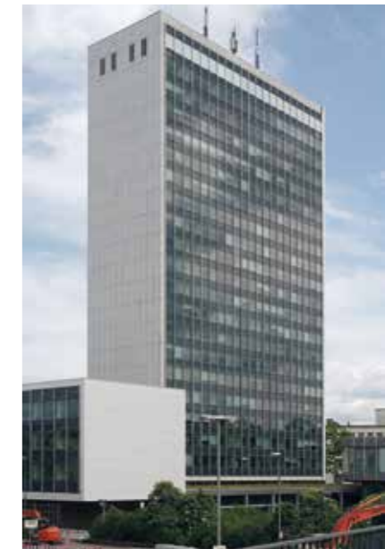
Die Vorhangsfassade des Badenwerk-Hochhauses ist schadhafte; nun soll der ganze Bau abgerissen werden. Foto: Sitacuisses / Wikimedia Commons, 2014
