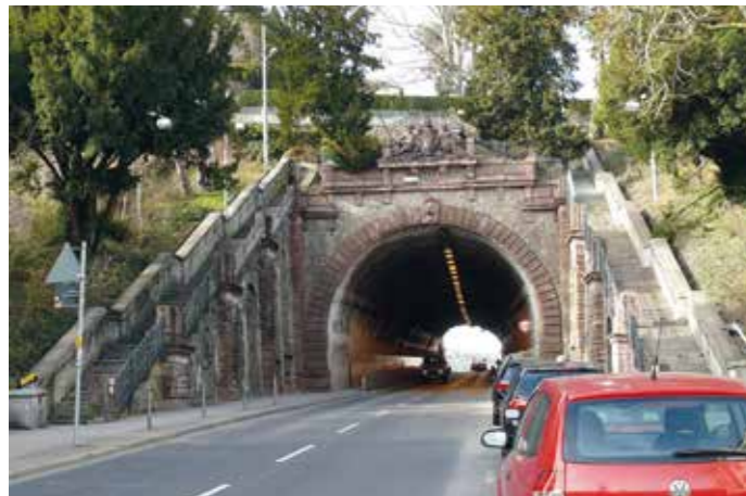
Das aufwendig gestaltete Südportal des Schwabtunnels liegt im Stuttgarter Stadtteil Heslach. Foto: Silesia711 / Wikimedia Commons, 2013
