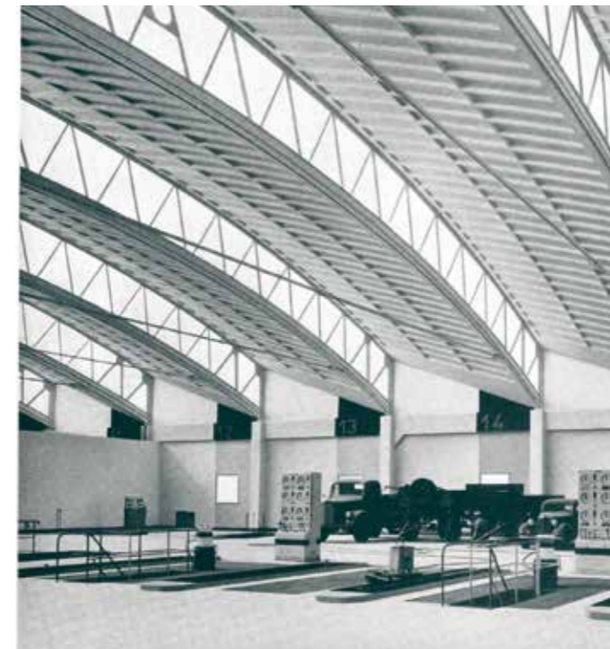
Die von Wilhelm Silberkuhl entwickelten Schalendächer symbolisieren den Aufbruch in moderne Zeiten. Foto: Sigrid Prinzenberg / aus: Jürgen Joedicke: Dokumente der modernen Architektur, Band 2: Schalenbau – Konstruktion und Gestaltung, Stuttgart 1962
