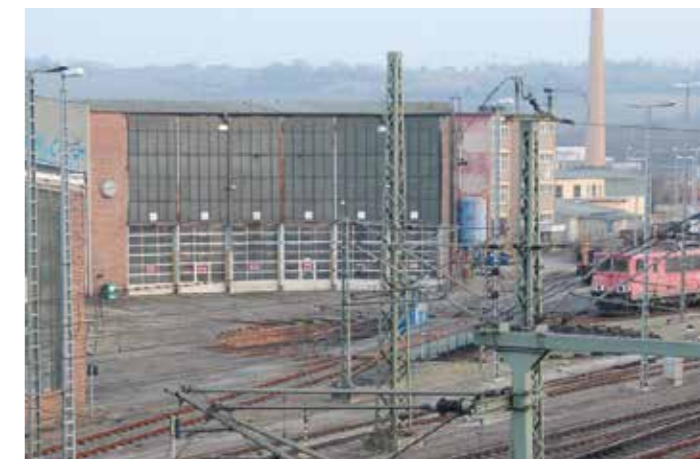
Der etwa 1972 eingeweihte Ringlokschuppen in Saalfeld zählt zu den wenigen in der DDR neugebauten Lokhallen. Foto: Sven Bardua, 2018
