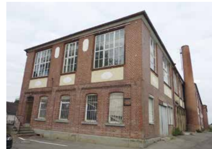
Der Schornstein weist auf die einstige Funktion des neuen Rathauses von Gomaringen. Foto: Wegner / Deutsche Stiftung Denkmalschutz
