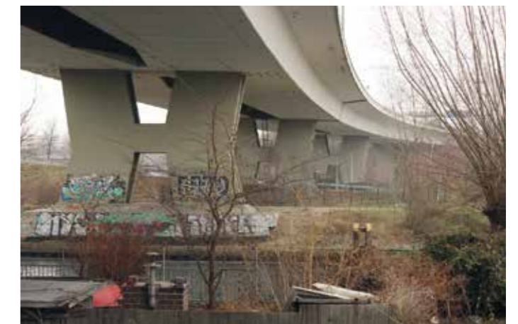
Die in einem 90 Grad-Bogen liegende Rudolf-Wissell-Brücke in Berlin wird von elf H-förmigen Stützen getragen und ist bis zu 16 Meter hoch. Foto: Sven Bardua, 2018
