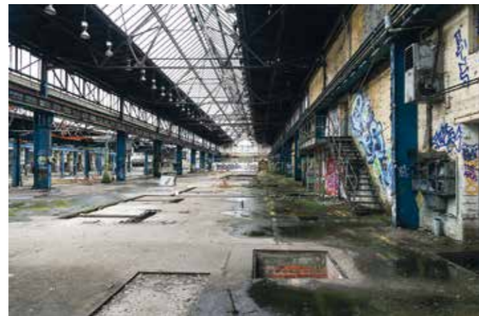
Bis 2021 soll in und neben der Neuen Halle des Ausbesserungswerkes Potsdam ein Gründer- und Innovationszentrum entstehen. Foto: Trockland Management GmbH
