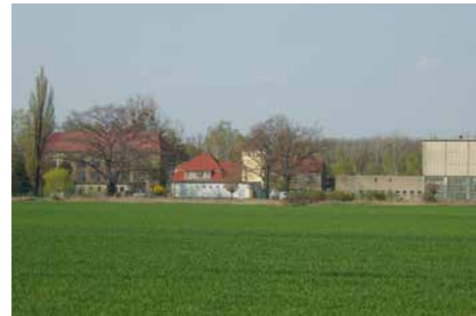
Das ehemalige Wasserwerk Buchwalde besteht aus (von links) einer Filterhalle, dem Wohnhaus, dem Schalthaus mit Trafoturm sowie einer aus DDR-Zeiten stammenden Halle mit der Enteisungskaskade dahinter. Foto: Z-thomas / Wikimedia Commons, 2009
