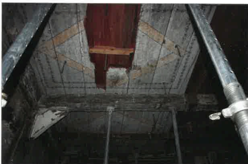
Aussteifungen im Inneren und Schablonenmalereien an der Decke des Erdgeschosses, Sachsen-tor 17. Foto: G. Dahms, 02.05.2019
