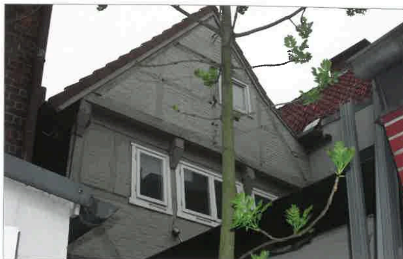
Rückwärtiger Fachwerkgiebel des Hauses Sachsen-tor 17 mit Ziersetzung bei der Backsteinausfachung. Foto: G. Dahms, 02.05.2019
