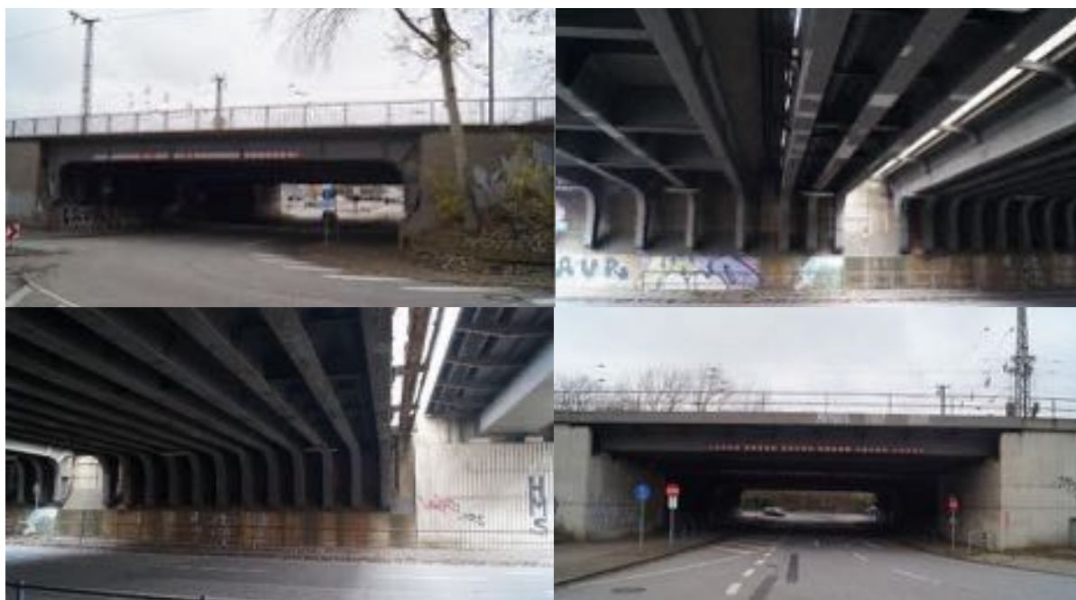
Abbildung 80: Unterführung der Tunnelstraße
