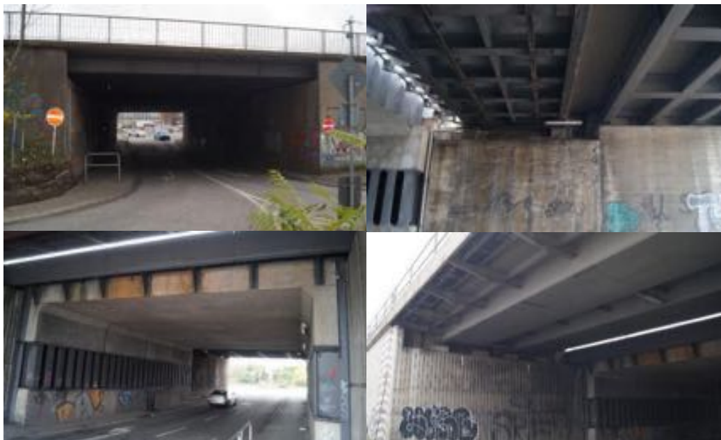
Abbildung 78: Unterführung der Straße Am Bahndamm
