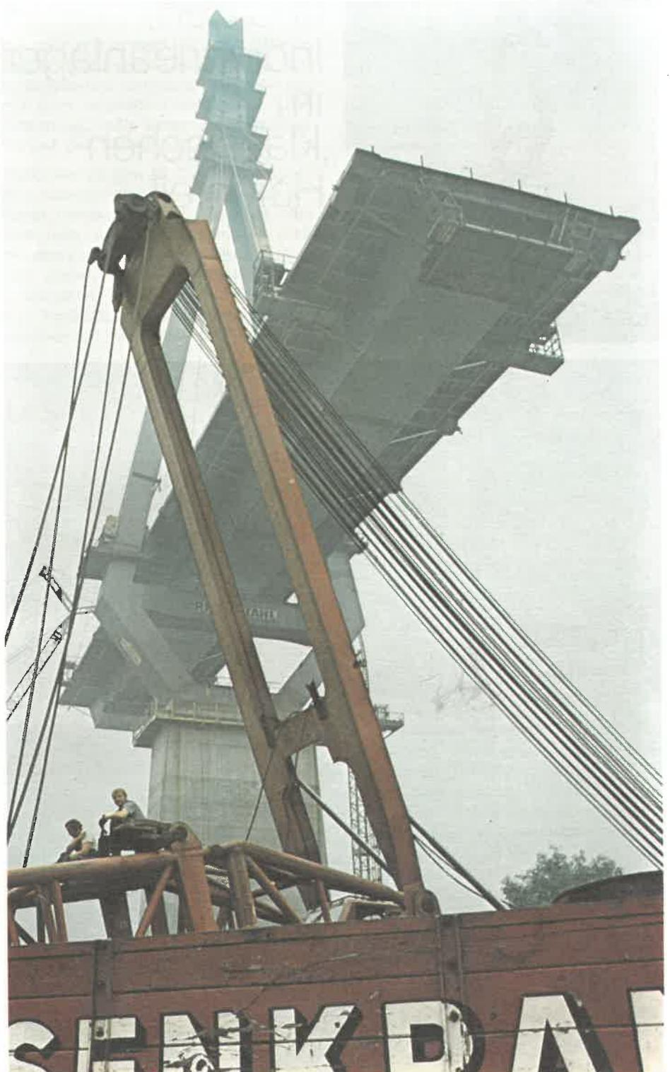
**Beispiel für wirtschaftliche Montageverfahren und Einsatz moderner Hilfsmittel der Fördertechnik: Der Zusammenbau des Versteifungsträgers. Aus 34 Großsektionen setzt sich das 520 Meter lange Herzstück des Bauwerks zusammen.**
