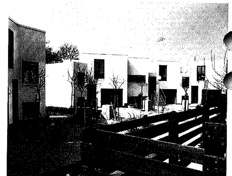
9 Haus Nr. 44-48 – Stadthäuser Architekten: Planungsgemeinschaft Steidle, Sandvoss und Sommerer (München) Bauträger: Norddeutsche Wohn- und Geschäftshaus GmbH
